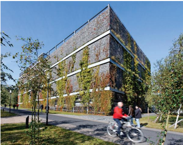
Figuur 59 – Parkeergebouw Philippsite, Eindhoven
