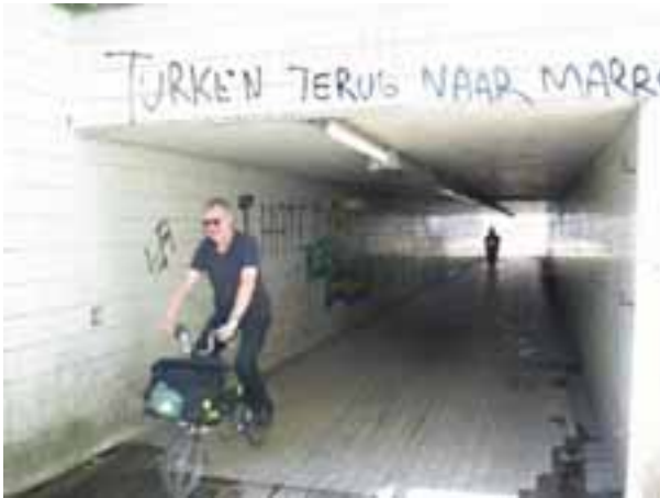
BESTAANDE FIETSTUNNEL OP KRUISPUNT 2
