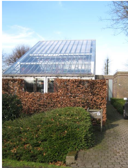
Figuur 20 Woning met architectenatelier – Parklaan 146
