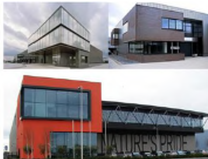
Figuur 36: Voorbeelden representatieve bedrijfsruimten als accent in de bedrijfsbebouwing
