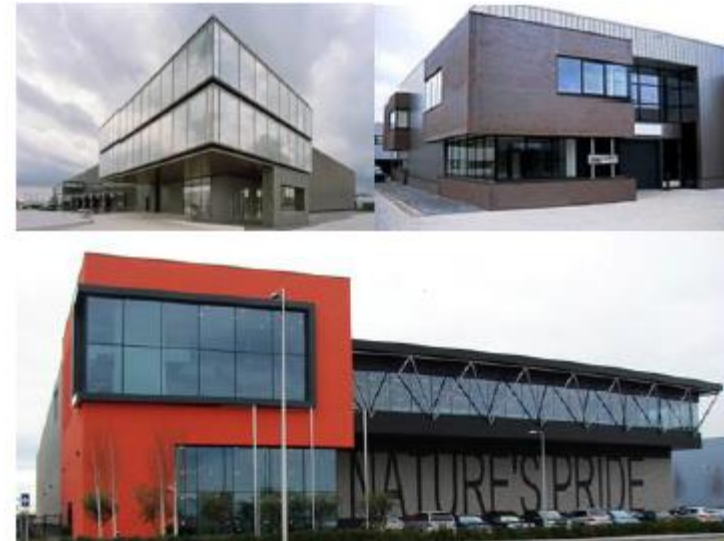
Figuur 35: Voorbeelden representatieve bedrijfsruimten als accent in de bedrijfsbebouwing
