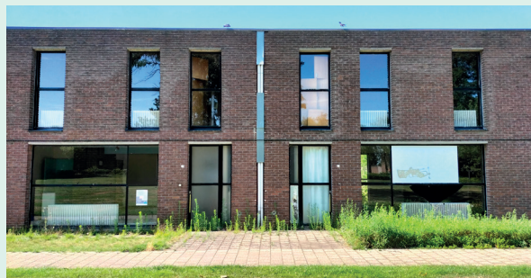
Asbestverwijdering en sloop
