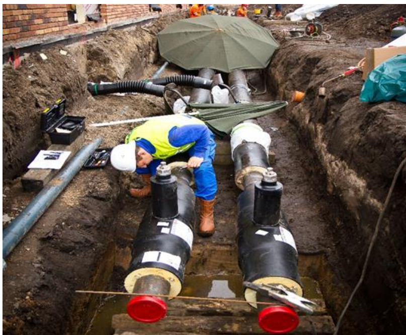
Figuur 29: Realisatie van het warmtenet op Niefhout (bron: https://www.turnhout.be/slimturnhout )
