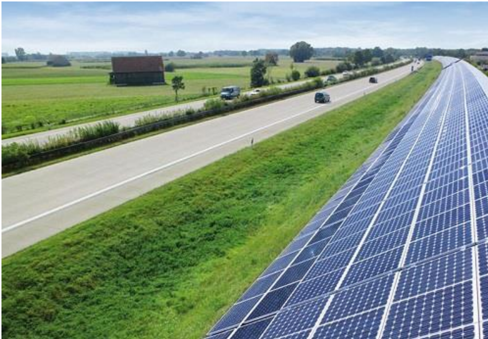
Figuur 79: Een zonnepaneelrij met 5.000 zonnepanelen langs de snelweg A12 bij Ede (NL)(Bron: Stichting Milieunet)
