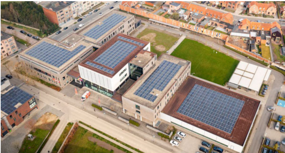
Figuur 38: zonnestroom installatie op de Thomas More Hogeschool Campus Turnhout (bron: Campina energie CV)
