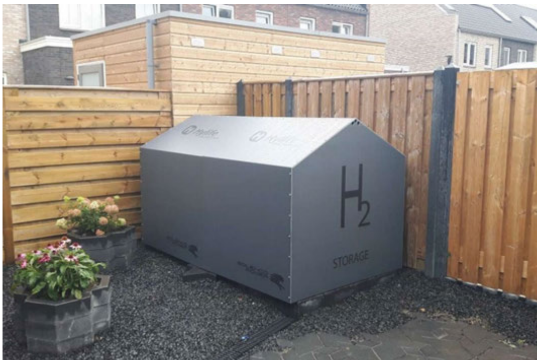
Figuur 36: Voorbeeld van de Solenco powerbox die een woning van warmte en elektriciteit voorziet op basis van waterstof (bron: Clean Tech Flanders)
