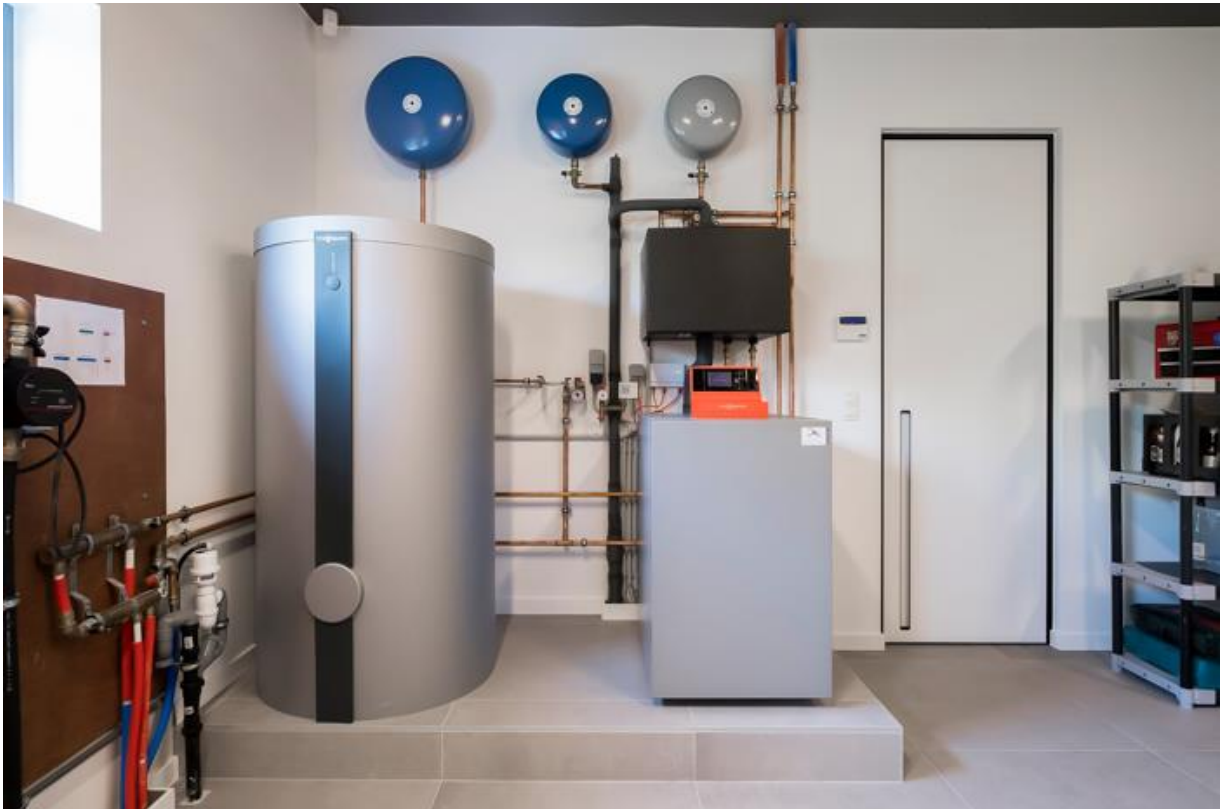
Figuur 34: Voorbeeld van een warmtepompinstallatie bij een woning (bron: warmtepomptechnieken.be)
