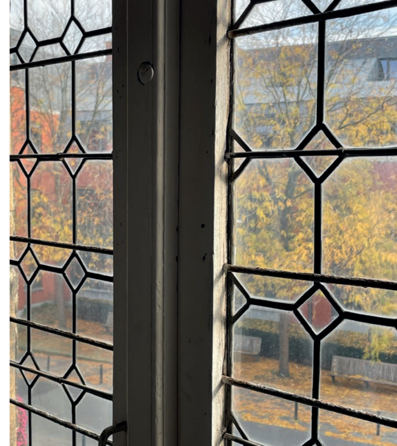
De originele ramen worden gerestaureerd en blijven behouden. Achterzetglas zorgt ervoor dat de ramen voldoen aan de huidige isolatienormen.
