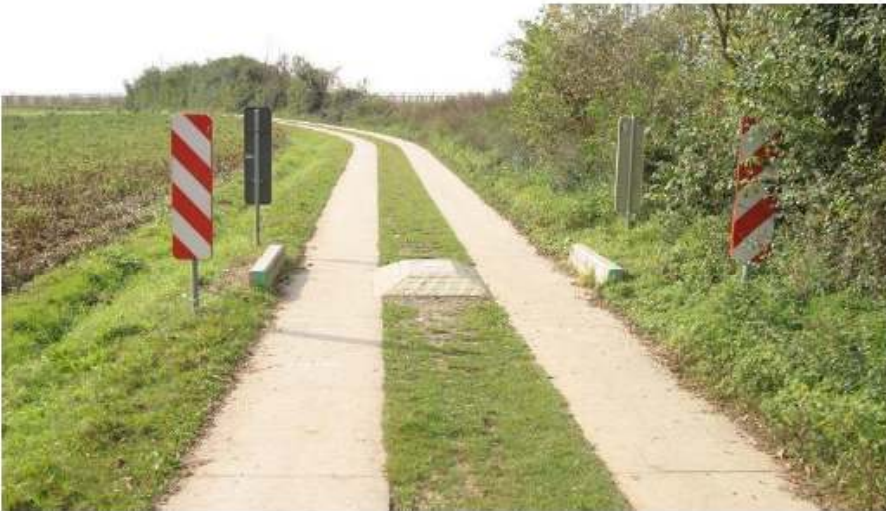
Voorbeeld fietsvriendelijke tractorsluis (Zaventem)
