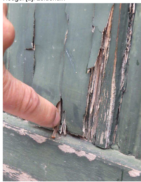
Vleugel [1]-zuid: de inkomdeur is onderaan beperkt ingerot
