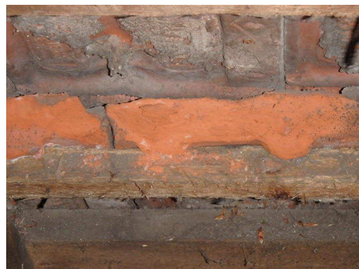
De neuzen van de pannen schilferen af
