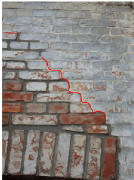
Harde herstellingen scheuren terug in
