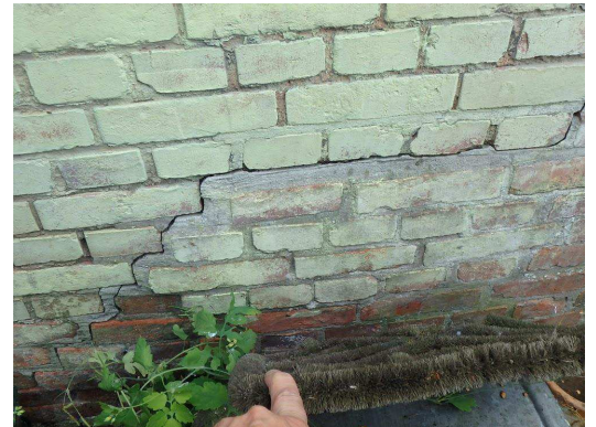
Vleugel [3]: zettingsscheur
