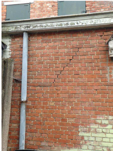
Vleugel [3]: zettingsscheur
