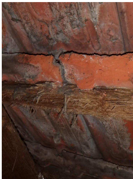
De panlatten zijn vezelig en sterk verweerd
