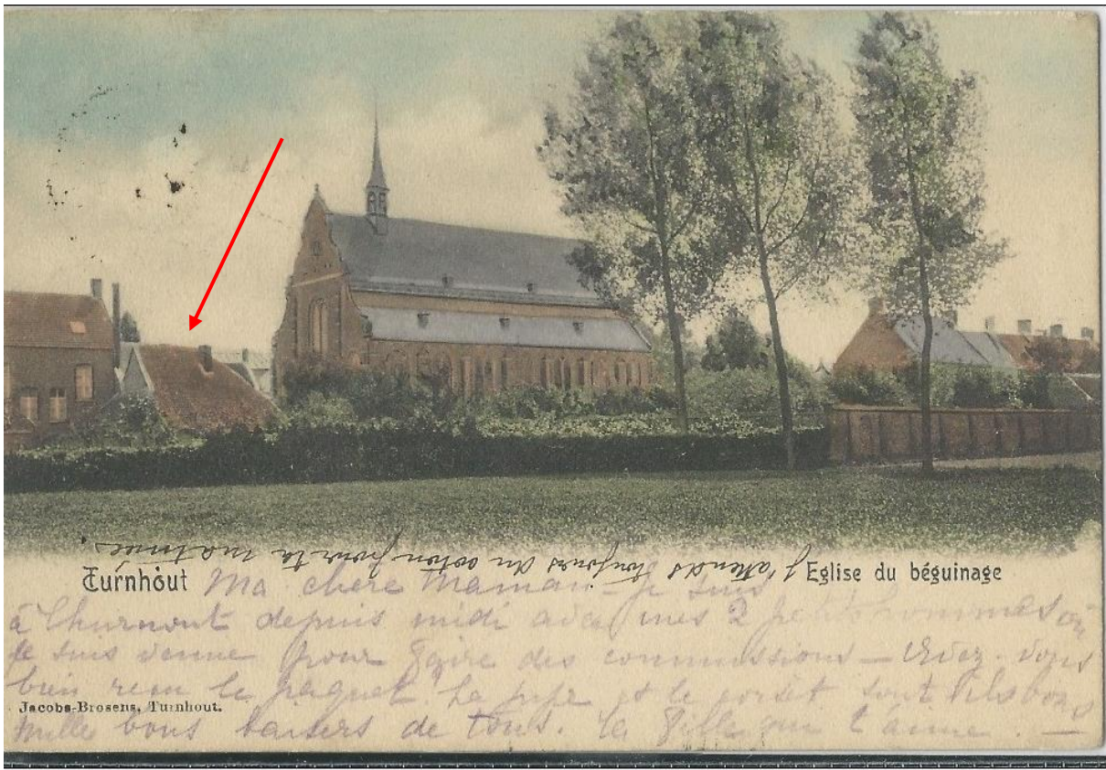
Figuur 7: postkaart, herderswoning nr. 58 – achterzijde begijnhof, 1908. BRON: www.delcampe.net – De achterzijde van het dak liep in één stuk door tot laag boven het grondniveau. Vermoedelijk volgde de herderswoning aanvankelijk de typologie van het Kempisch woonhuis.
