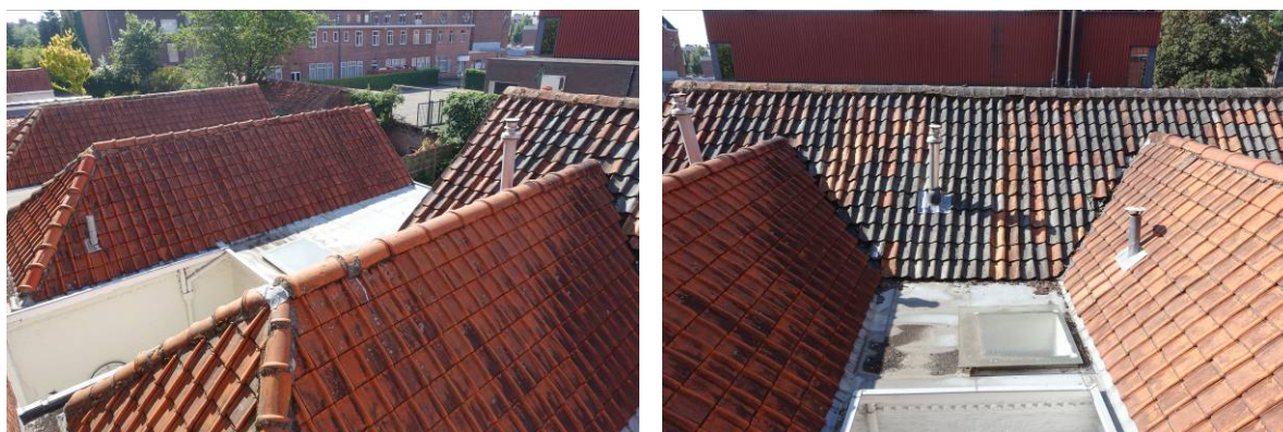
Afbeelding 19: het dak van de aanbouw
