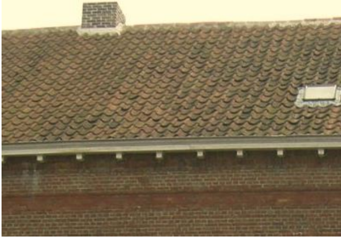
Afbeelding 10: het dak en de kroonlijst
