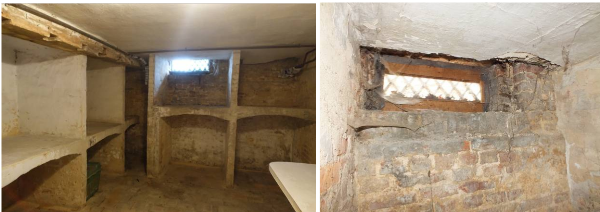
Afbeelding 27: het plafond in de kelder
