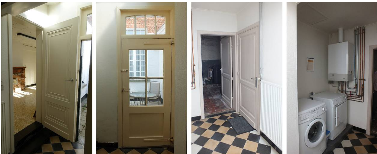
Afbeelding 33: doorgangen vanuit de sas
