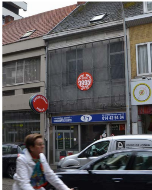
ZEER GESLOTEN GEVEL
