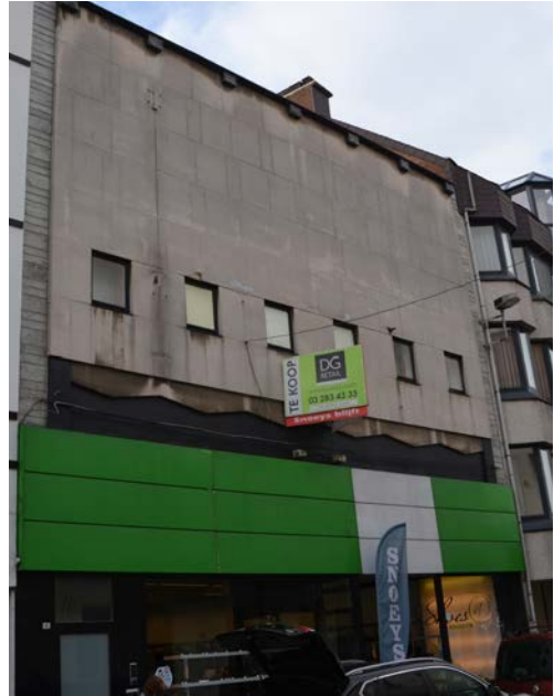
ZEER GESLOTEN GEVEL
